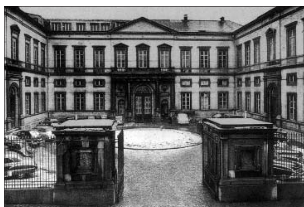
Entrada del Hospital Saint Pierre, de Lovaina en 1950. Entrance to Hôpital Saint Pierre, Lovain in 1950.
